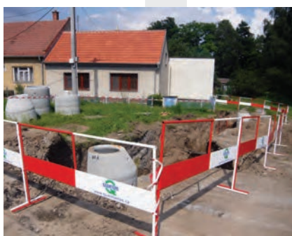
2017 – Stavíme vodárenskou infrastrukturu
