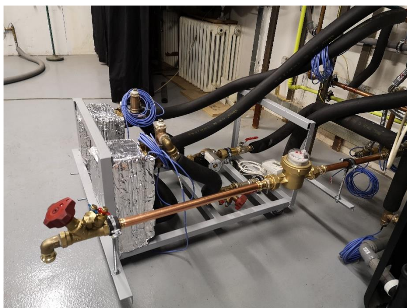
Obr. 4 QH-Prototyp modulární systém po připojení na otopnou soustavu haly ČVUT
